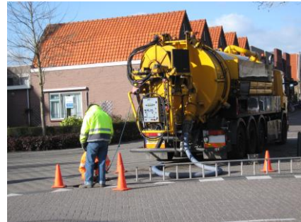
Reiniging en inspectie van riolering.
