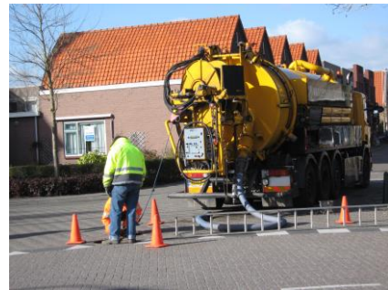
Reiniging en inspectie van riolering.
